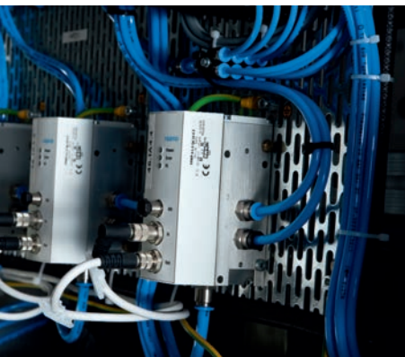
优异的运动性能：比例方向控制阀 VPWP。
